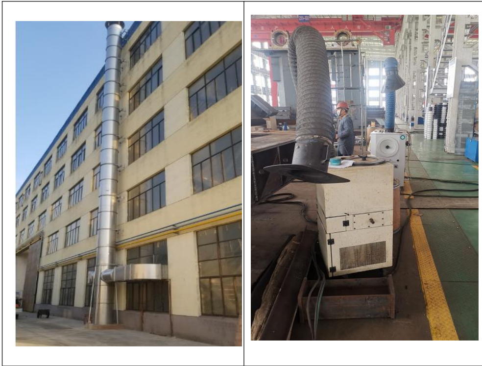
图 4.1-4 废气处理设施
